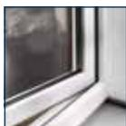
Kontrollieren Sie die Dichtigkeit zwischen Flügel und Blendrahmen sowie den richtigen Sitz der Dichtungen. Lassen Sie beschädigte Dichtungen austauschen.
